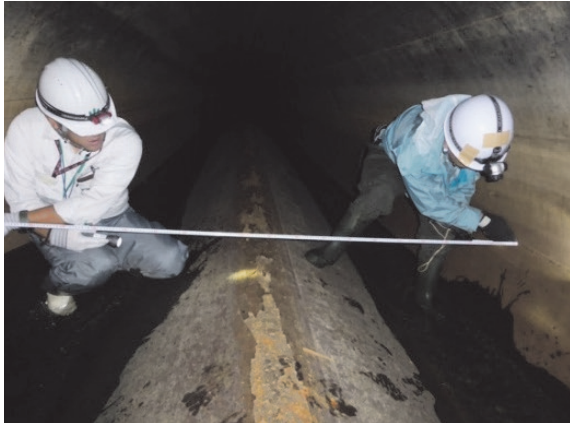
写真1 現況水路トンネル
