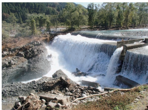
写真-2 護床ブロックの流出
