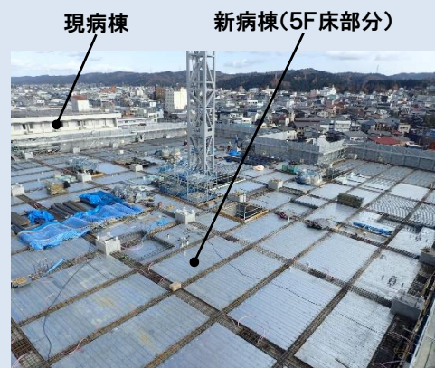
新病棟建設現場の状況 (H30年11月末現在)
