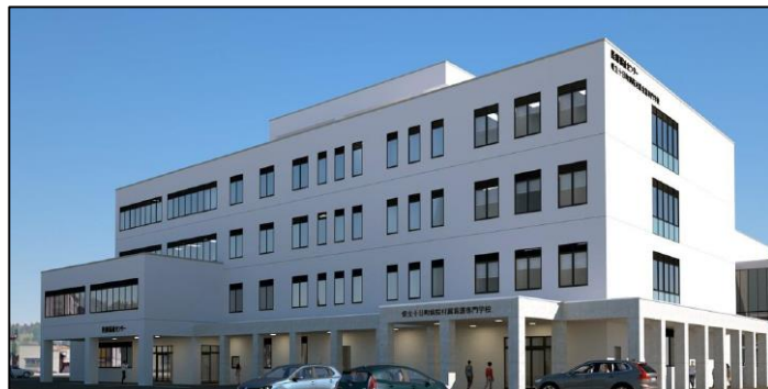
「十日町市医療福祉総合センター（仮称）」 ＜今年秋頃竣工予定＞内に整備しています。
