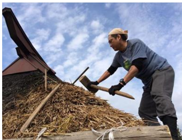
インターン生が茅葺きの修繕作業を 行っている様子
