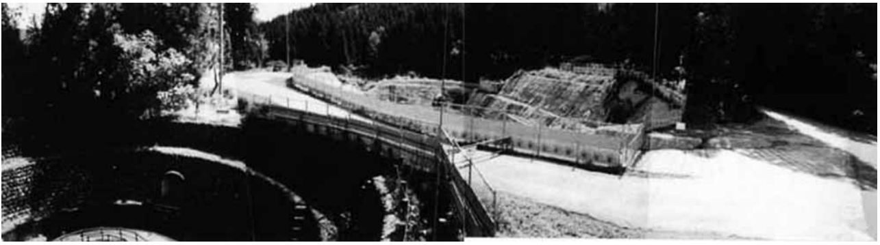
左下：旧円形分水工 右上：新円形分水工（施工中）
