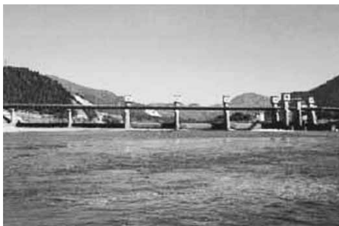
阿賀野川頭首工
