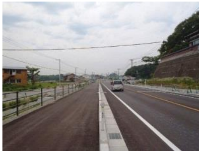
拡幅後の状況（秋津地内）（平成27年10月）
