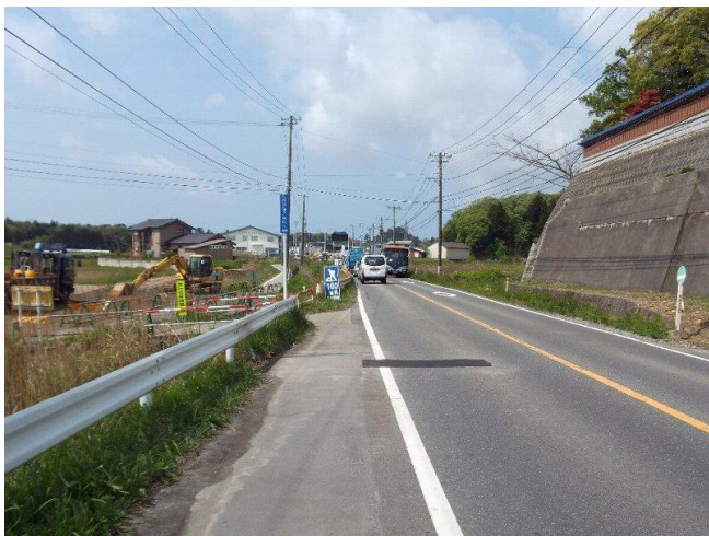
拡幅前の状況（秋津地内）（平成26年8月）
