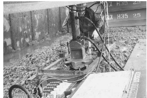
載荷試験実施状況
