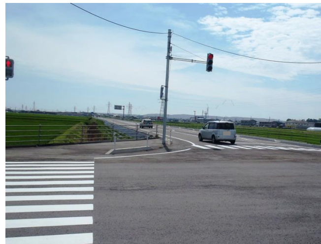
長木～八幡間の開通後の状況（平成27年6月）
