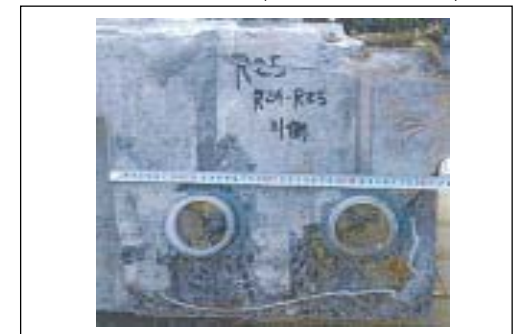
R24～R25のPC鋼材破断状況 (R25のR24側:信濃川側)
