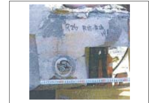
R25～R26のPC鋼材破断状況 (R26のR25側:信濃川側)
