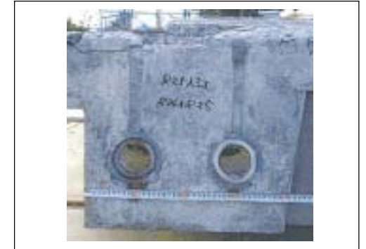
R24～R25のPC鋼材破断状況 (R25のR24側:信濃川側)
