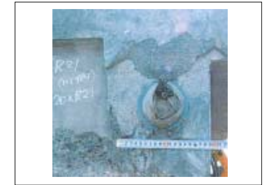
R25～R26のPC鋼材破断状況 (R26のR25側:信濃川側)
