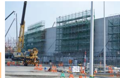
③3号機海側（2月28日撮影）
