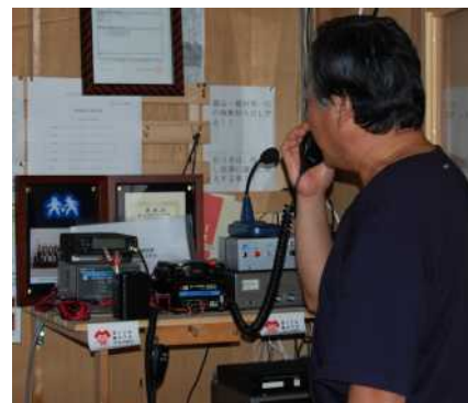
集落開発センターにある無線機 ここから町内全体に放送します
