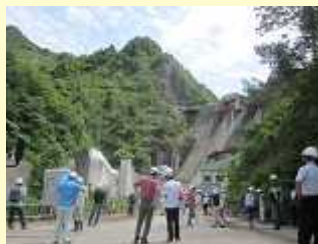
笠堀ダム嵩上げ工事現場見学
