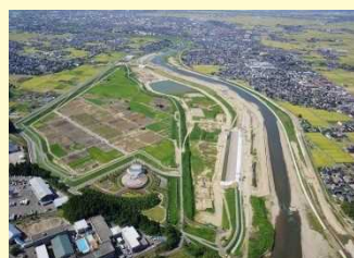
五十嵐川遊水地工事現場見学
