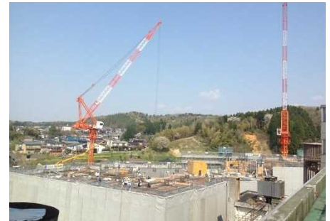
加茂病院改築工事
