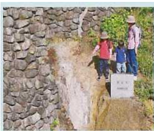
6. 糸静線と塩の道 (北部) 断層露頭と古道
