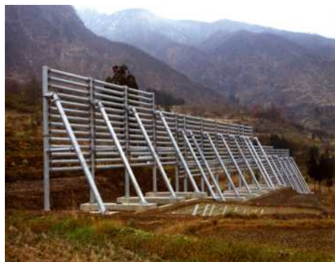
雪崩をその場所で止める防護工
