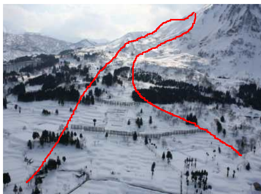
二度と同じ悲劇を繰返さない為に、柵口地区に昭和61年～平成4年にかけて、減勢工127.8m、防護工311mを施工しました。減勢工は発生した雪崩の勢いやエネルギーを弱め速度を遅くし、集落の手前で止める
