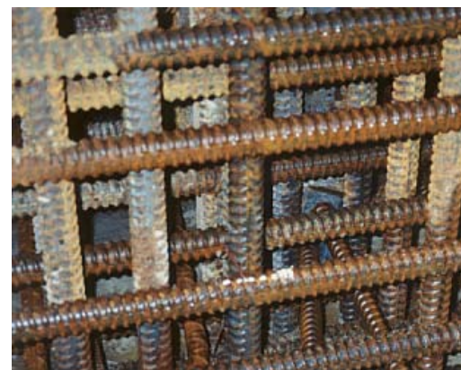
7号機原子炉建屋の配筋例
