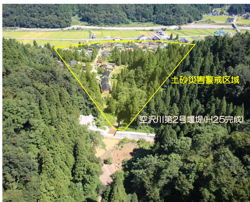
土石流発生後 (H28.8.25撮影)
