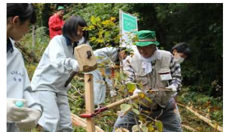
【斜面での支えの打ち込み】
