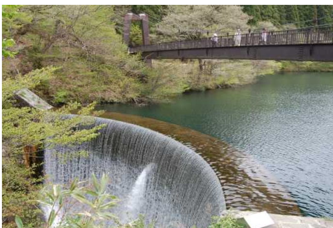
昭和14年に建設されたえん堤
