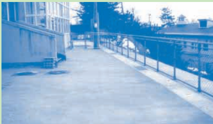
はまなす養護学校の復旧後の様子(H19.10)
