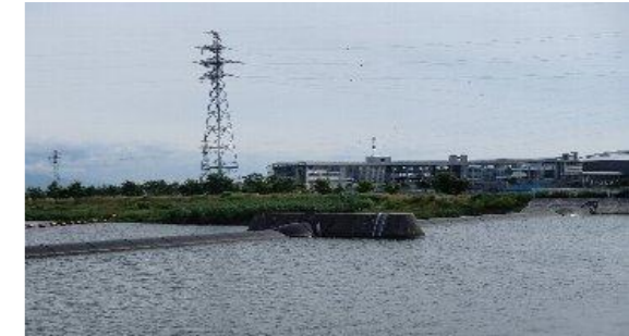
椋堰が、福島潟と放水路の水を分けている。水位差はおよそ1.5m。堰の前方には日本を代表する建築家が設計したという葛塚中学校が見える。
