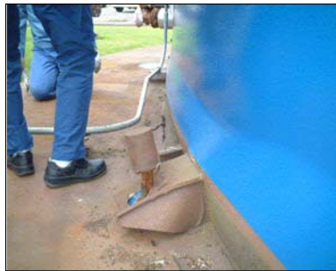
基礎ボルト，ブラケット破損
