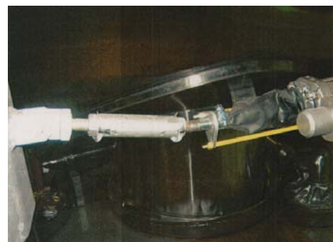
軸圧縮方向に過大な荷重が作用し座屈したオイルスナバ
