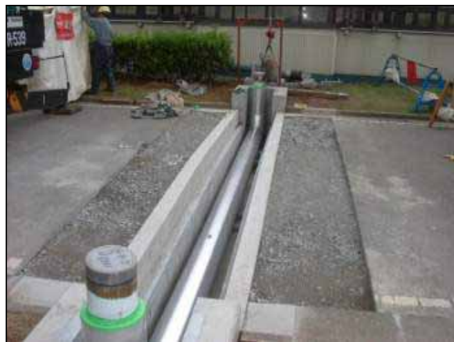
消火配管のトレンチ化
