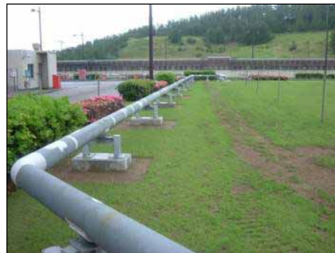
消火配管の地上化
