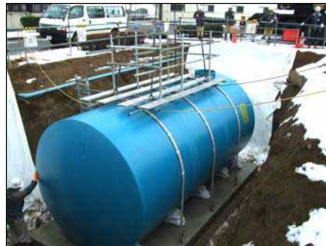
耐震防火水槽設置
